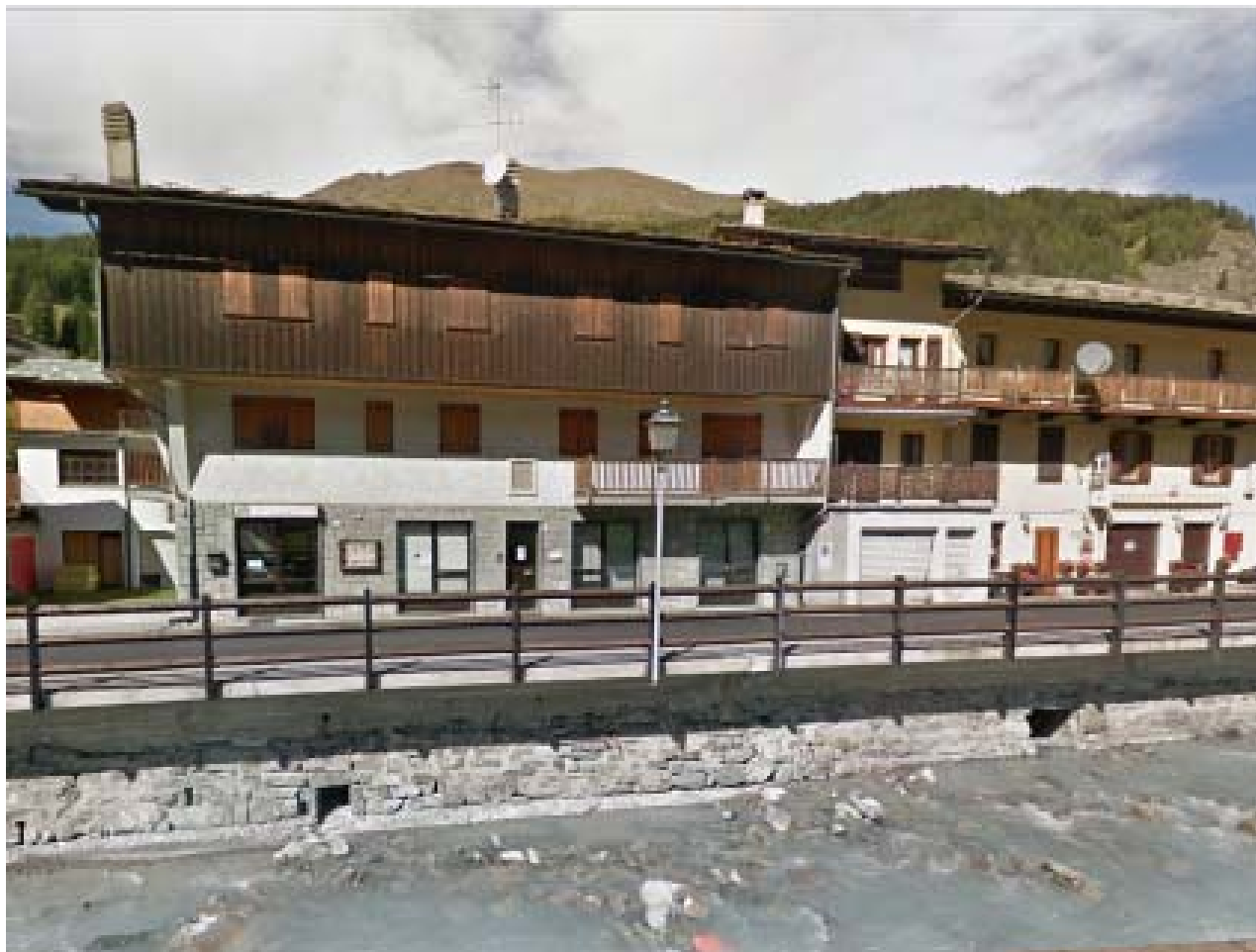
Foto 3 - scarichi da far confluire nel collettore
