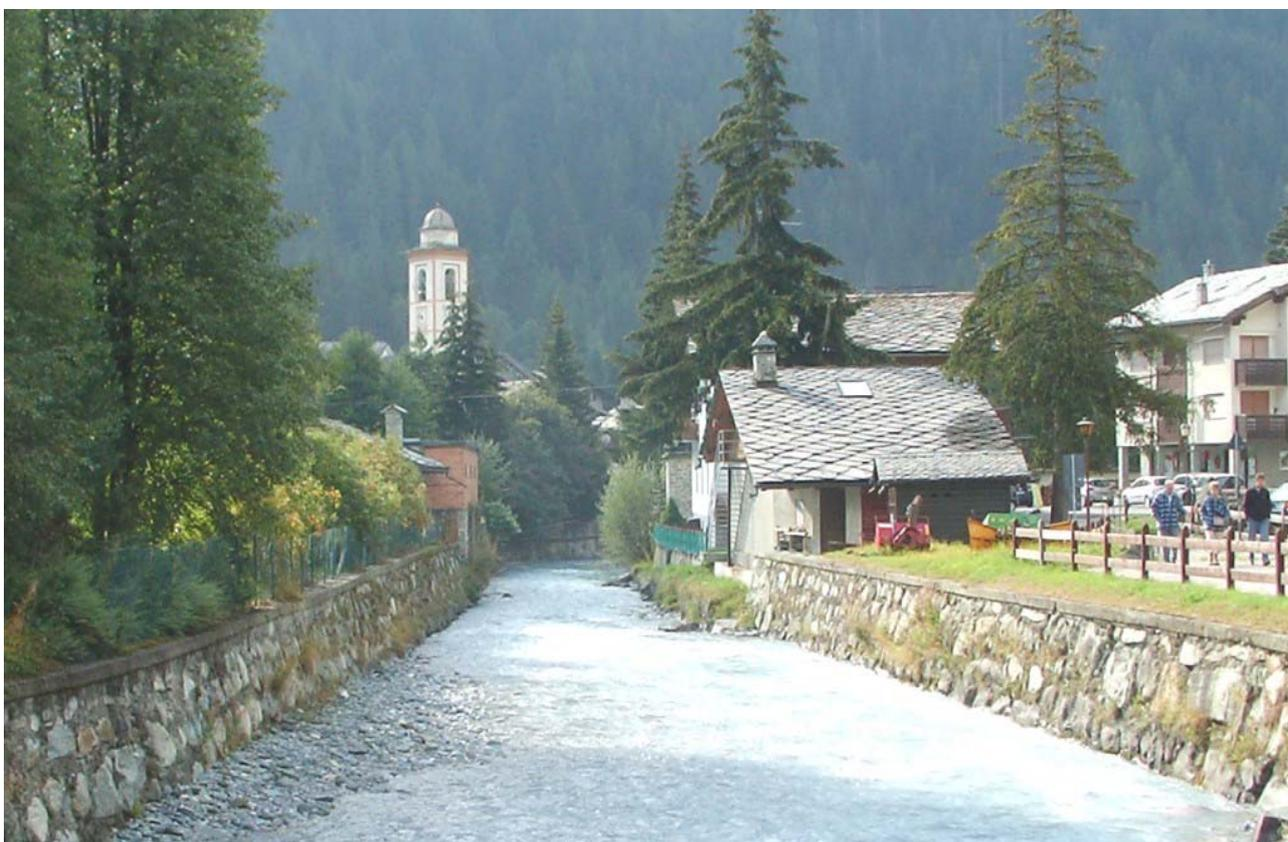
In destra orografica si può notare un rinforzo fatto con gabbioni alla base della fondazione del muro d'argine sui cui è appoggiata la casa. Tale gabbione, oltre a restringere la sezione utile, presenta punti di cedimento.
