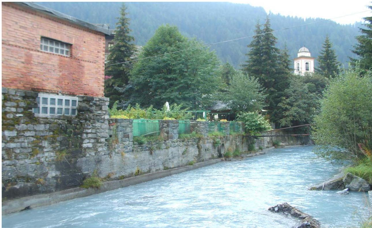
Scendendo si arriva al ponte di Rue Des Guides che, come indicato dalla relazione degli ambiti di inedificabilità per esondazione, vigente, costituisce un grave elemento di criticità , in relazione alla sezione utile in tale punto, oltre che rispetto all'andamento planimetrico del corso d'acqua. In questo punto infatti, successivi rimaneggiamenti dell'alveo, hanno determinato una brusca curvatura verso destra che contribuisce ad accentuare la perdita di energia in questo punto critico.
