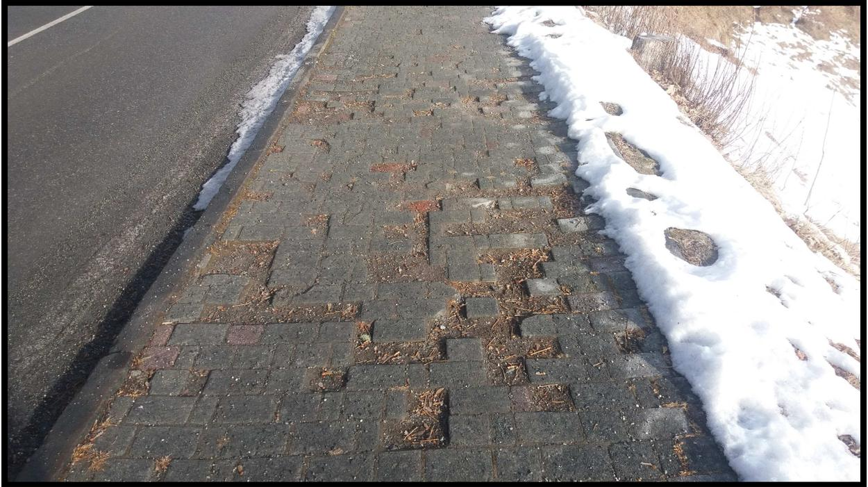
Foto 5 – Pavimentazione in cubetti in cls fortemente ammalorata
